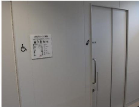
多目的トイレの例(奈良県山添村庁舎)
